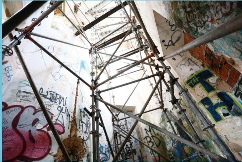
Escoras metálicas que sustentavam o interior do prédio deteriorado após cobrança do Ministério Público. Foto: Tiago Stille (Governo do Ceará).
